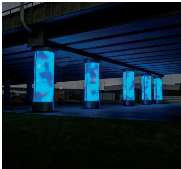
De computergestuurde ledverlichting is op allerlei manieren in te stellen: van statisch beeld tot dynamische lichtscènes.
